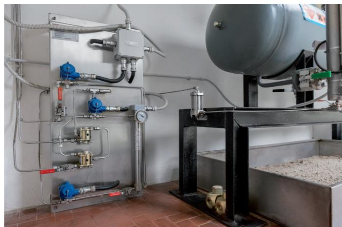
la cabina principale completo di dispositivi a controllo elettronico, consente di gestire in modo “intelligente” la temperatura del gas in uscita e dell’acqua utilizzata negli scambiatori di calore tenendo conto della temperatura del gas in entrata ed in uscita, della
